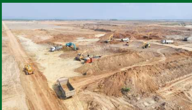
Xe cơ giới thi công cải tạo mặt bằng tại Khu liên hợp, đảm bảo tiến độ và chất lượng các công trình trên đất
